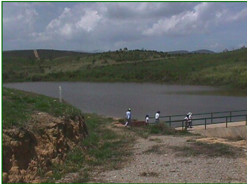
Fotografía. Represa de Piedras Negras. Bocatoma del Acueducto de la cabecera municipal de Lebrija, ubicado en la vereda Piedras Negras.
