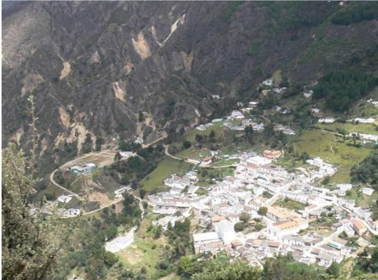
FOTO 61. EXPLOTACIÓN MINERA EN INMEDIACIONES DEL CASCO URBANO DE VETAS DONDE SE OBSERVAN LA ALTERACIÓN DE LA COBERTURA VEGETAL Y LOS DESLIZAMIENTOS OCASIONADOS POR ESTA ACTIVIDAD
