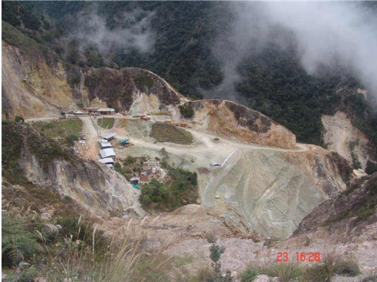
FOTO 60. IMPACTOS DERIVADOS DE LA ACTIVIDAD MINERA EN SECTOR ALEDAÑO AL PROYECTO ANGOSTURAS – MUNICIPIO DE CALIFORNIA
