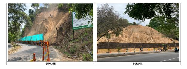
Además de las labores preliminares se han ejecutado actividades de 52,5 m3 de llenado de inyección de lechada cementicia para anclajes, actividades de desmonte, limpieza y perfilado manual descolgado del talud, 70 m3 de llenado de inyección de lechada cementicia para anclajes, 1260 ml de anclajes entre 0-15m
