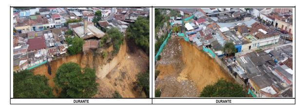
Frente de obra del barrio Girardot: Se han realizado labores preliminares de cerramiento, perfilado manual de taludes e inicio de la ejecución de perforaciones, excavación a mano descolgada para zapata 22 m3, y 250ml de perforaciones descolgados para anclajes superiores a 15m, por señalar sólo algunas relevantes.
