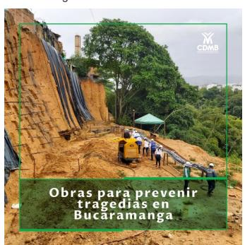
pantallas ancladas, que mitiguen el riesgo de deslizamientos en los barrios Girardot, Campohermoso y en el Puente El Bueno. La intervención consiste en una estabilización para controlar la erosión y evitar deslizamientos rocosos sobre la vía. Conservar la vida de los seres humanos y mitigar los riesgos es la principal finalidad de estos tres proyectos.
