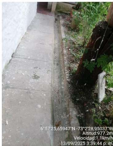
Fotografía 7. Canales perimetrales internos
