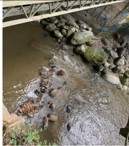
Fotografía No.2. Curso de la fuente hídrica denominada Río Frío – sector puente rojo.
