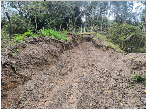
Fotografía 11. Apertura de vía.
