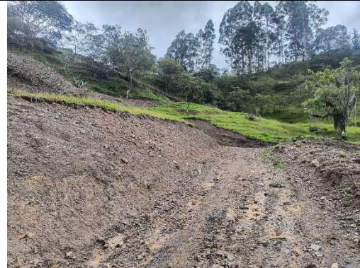
Fotografía 8. Apertura de vía.
