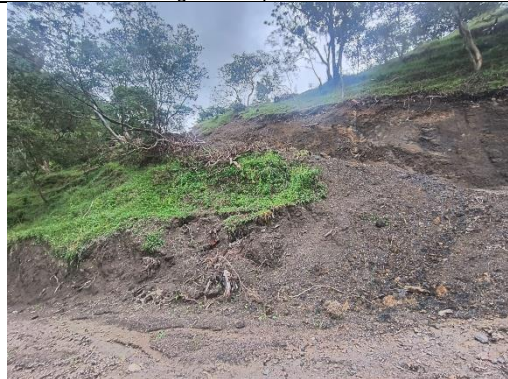
Fotografía 10. Apertura de vía.
