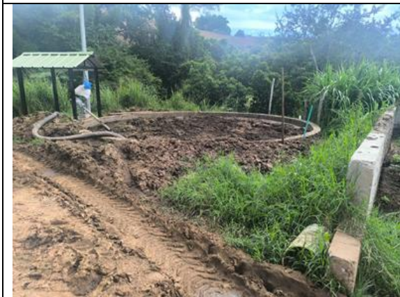
Fotografía 3. Sistema circular para la recolección de heces fecales con reboses y disposición en el recurso suelo
