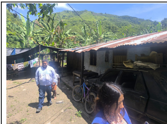
Fotografía 1. Vivienda instalada en ronda hídrica.
