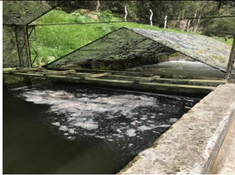
Fotografía 5. Desarenador.
