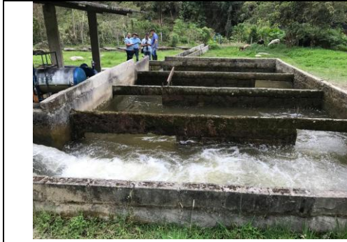
Fotografía 9. Canal a través del cual se descarga el rebose de los estanques.
