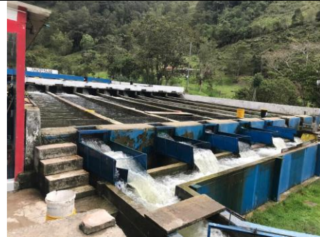
Fotografía 6. Estanques en concreto ubicados en franja de protección del Río Manco.
