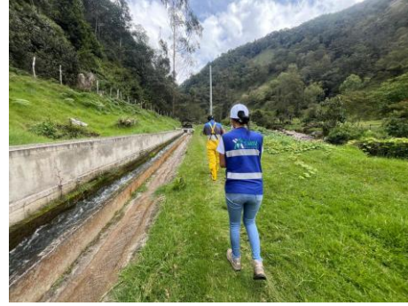
Fotografía 4. Canal en concreto de aproximadamente 55 m que conduce al desarenador.
