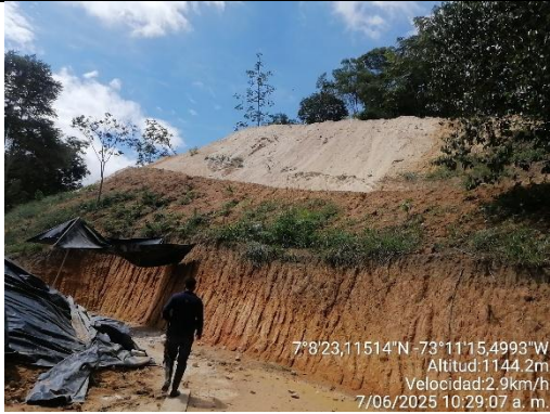
Fotografía 9. Corte de talud en terraza 3
