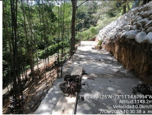
Fotografía 10. Obra en construcción en Terraza 3
