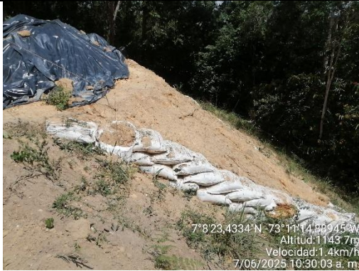
Fotografía 13 Hilera de sacos de suelo apilados desde base de la terraza 3 hacia abajo
