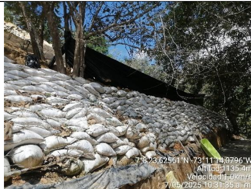
Fotografía 12. Medida de contención de material excavado sobre ladera vista desde terraza 3 hacia arriba
