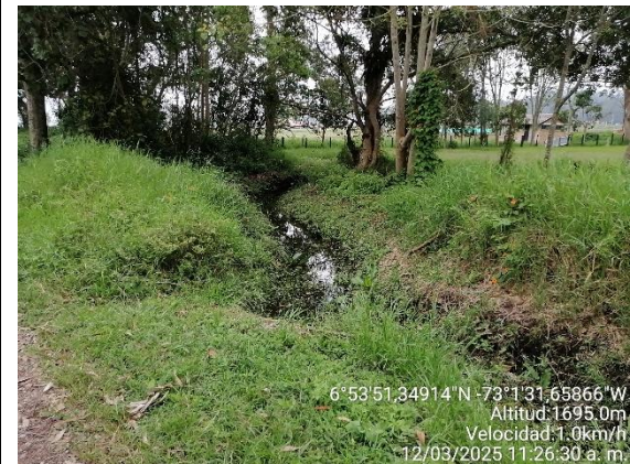
Fotografía 6. Zanja que lleva todas las aguas recolectadas en la zanjas de la vía hacia el lago artificial
