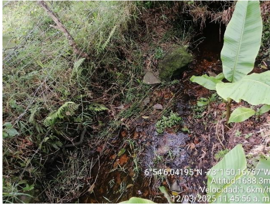
Fotografía 3. Zanja de desembocadura interna conjunto residencial Altamira 7
