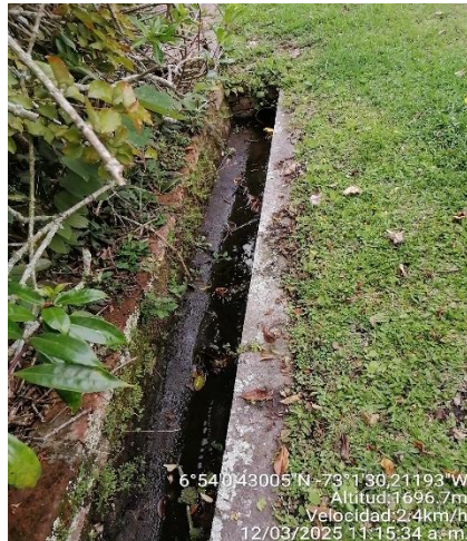
Fotografía 5. Terminación de zanja donde cruza la vía desde lateral conjunto Pinares del Lago a zanja hacia el lago
