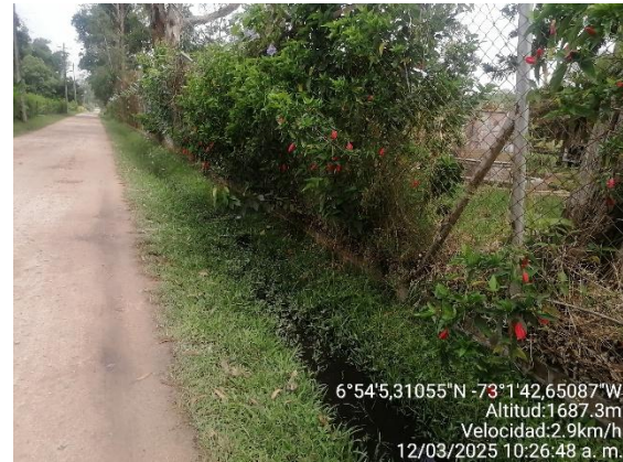
Fotografía 6. Zanja externa de la vía frente a conjunto Altamira 7
