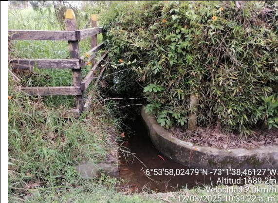
Fotografía 6. Unión de zanja de aguas lluvias Altamiras Reservado y conjunto Pinares del Lago
