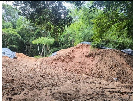
Fotografía 4. Acopio de tierra.
