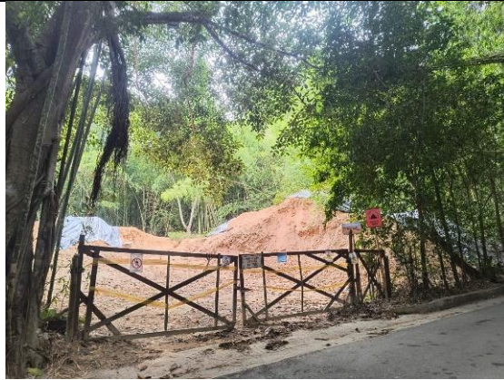
Fotografía 1. Portón de acceso al predio.
