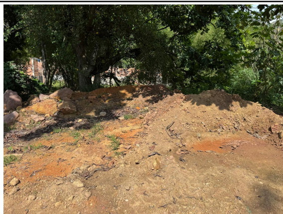
Fotografía 3. Área objeto de relleno con RCD
