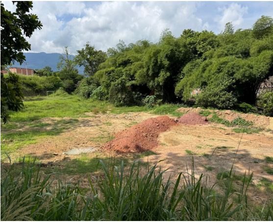
Fotografía 7: Área objeto de relleno con RCD
