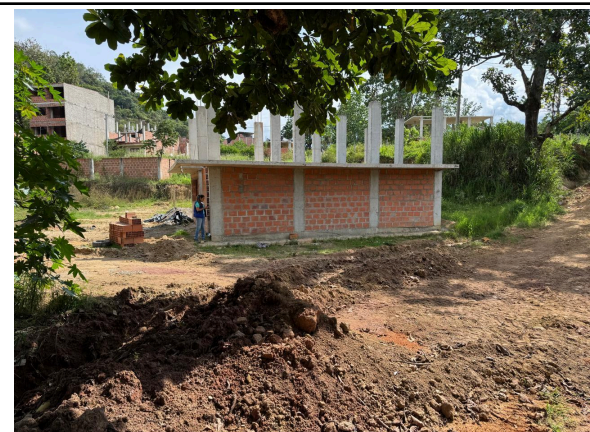
Fotografía 2: Proceso de construcción cerca a la fuente hídrica.
