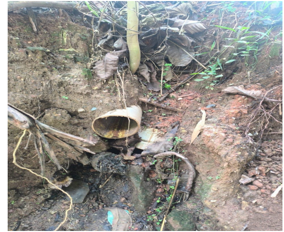
Fotografía 8: Tubería de descarga de ARD
