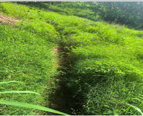
Fotografía 9: Zanga conducción de aguas lluvias
