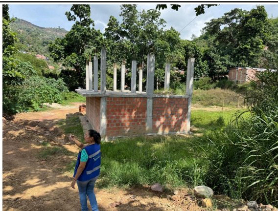
Fotografía 1. Proceso de construcción cerca a la fuente hídrica.
