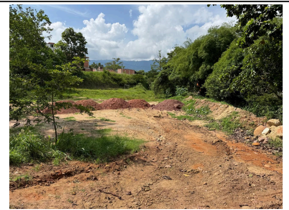
Fotografía 4. Área objeto de relleno con RCD
