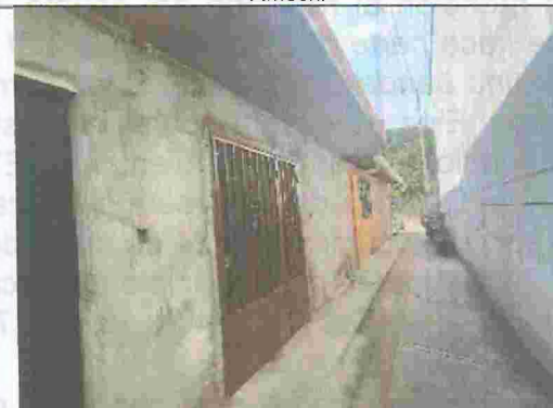
Fotografía No. 4. Vivienda del sector Granjas de Julio Rincón.
