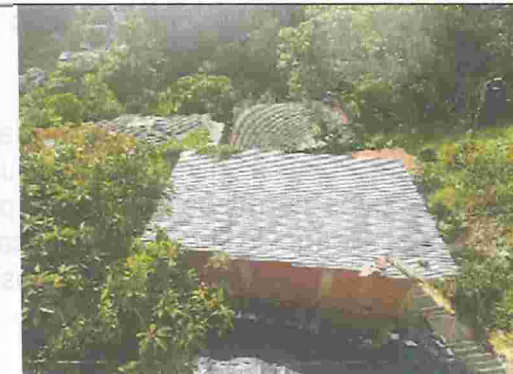
Fotografía No. 5. Vivienda del sector Granjas de Julio Rincón.
