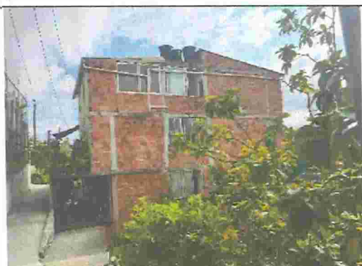
Fotografía No. 1. Vivienda del sector Granjas de Julio Rincón.
