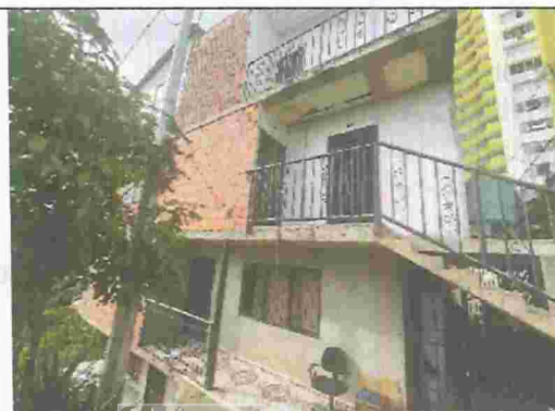
Fotografía No. 2. Vivienda del sector Granjas de Julio Rincón.
