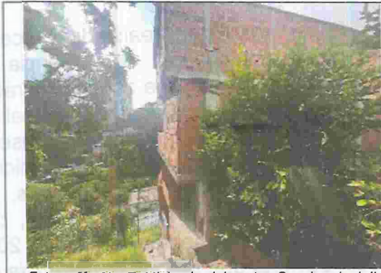
Fotografía No. 7. Vivienda del sector Granjas de Julio Rincón.
