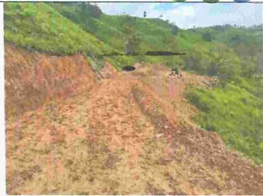
Fotografía No. 6. Apertura de vía y maquinaria tipo minicargador.
