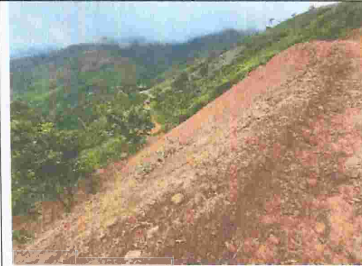
Fotografía No. 8. Material dispuesto sin medidas de control y/o contención.
