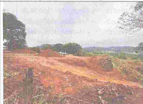
Fotografía No.4. Actividades de movimientos de tierra realizadas en el sitio.
