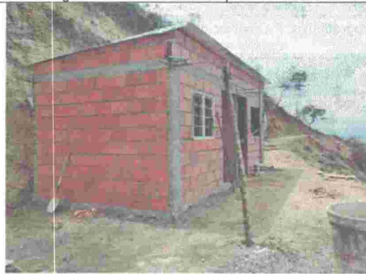
Fotografía No. 16. Construcción de edificación de un nivel.
