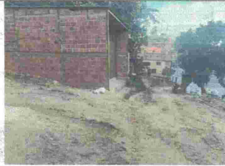
Fotografía 18. Adecuación, nivelación de terreno y vivienda en mampostería
