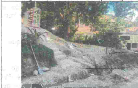
Fotografía 3. Adecuación, corte y nivelación de terreno
