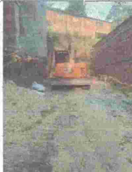
Fotografía 19. Corte, adecuación y nivelación de terreno.
