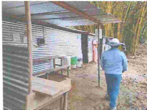
Fotografía 7: Campamento de obra
