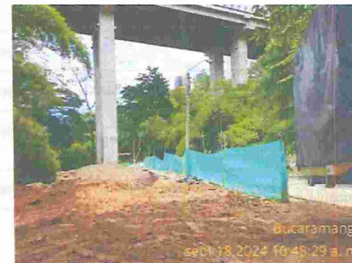
Fotografía 12: frente de obra debajo del viaducto la Flora
