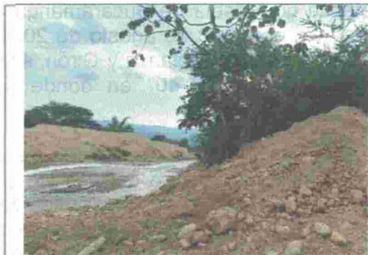
Fotografía 1. Área de intervención por obra
