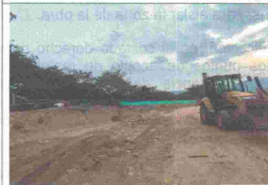
Fotografía 3. Área de intervención- maquinaria obra
