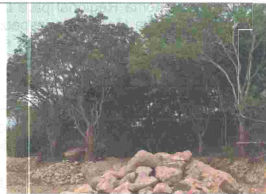
Fotografía 2. Individuos forestales afectados obra.
