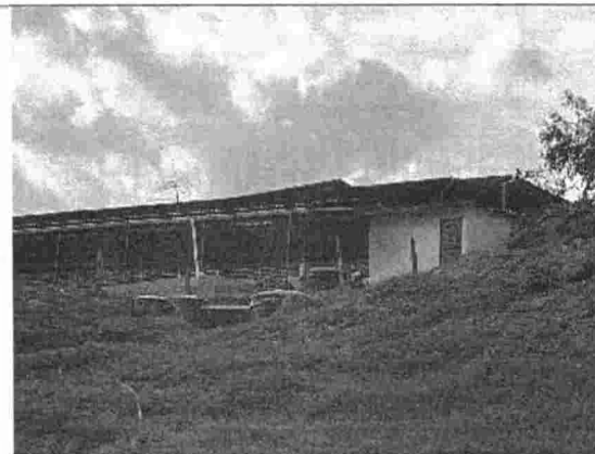
Fotografía 5. Tanques plásticos para recolección de excretas.
