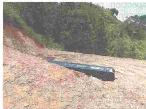
Fotografía No. 2. Área reconfigurada para instalar la casa prefabricada
