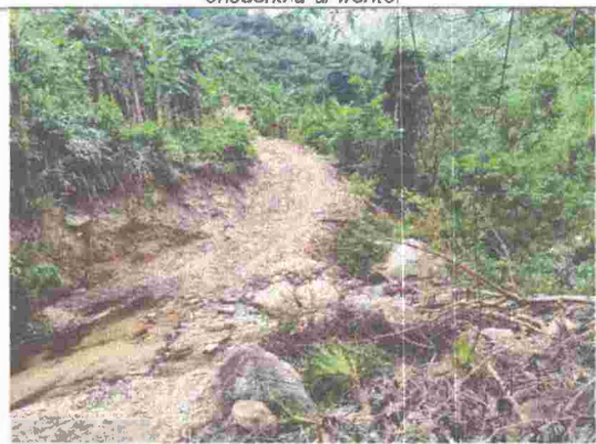
Fotografía No. 3. Vista de la vía desde la quebrada.
