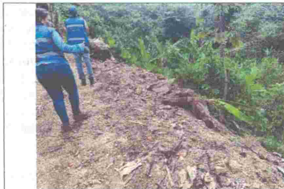
Fotografía No. 17. Tocones de árboles a un costado de la vía
