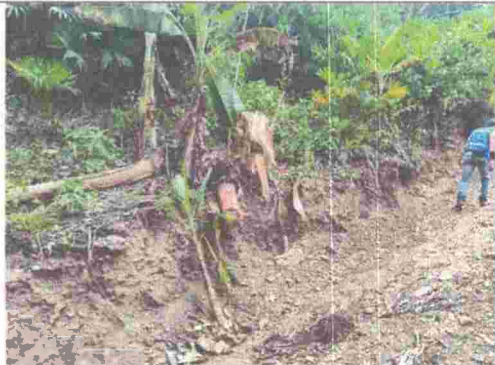
Fotografía No. 15. Costados de la vía.
