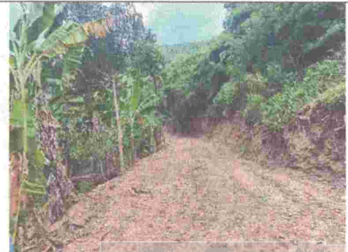
Fotografía No. 14. Condiciones actuales de la vía.
