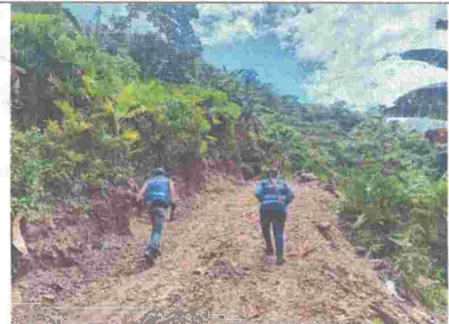
Fotografía No. 16. Condiciones actuales de la vía.
