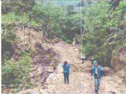
Fotografía No. 11. Intersección de l vía y fuente hídrica.
