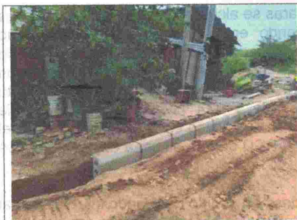
Fotografía -9 Área de intervención vías e instalación de sardineles.
