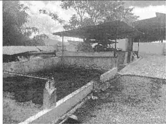
Fotografía 10. Lechos de secado y área donde se almacena el compostaje.
