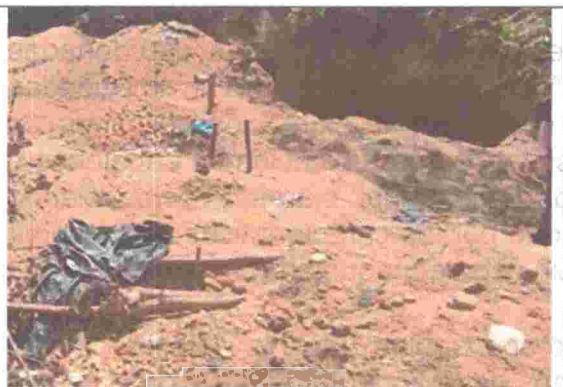
Fotografía No.3. Horcones para instalación de canalones de madera
