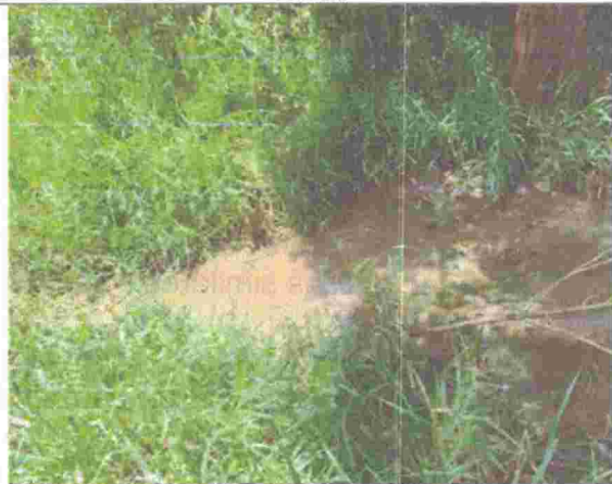
Foto 4. Acumulación de aguas en otro punto (colindante con la vía de acceso a la vereda).
