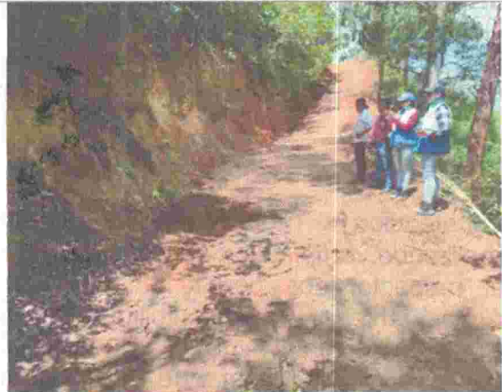
Foto 2. Acumulación de aguas en la vía de acceso a la vereda.
