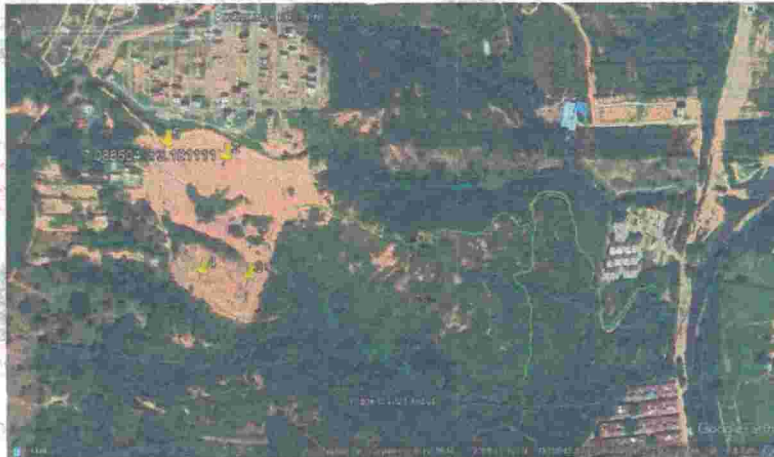
Fotografía No. 7. Condiciones del terreno 17 de octubre de 2024
