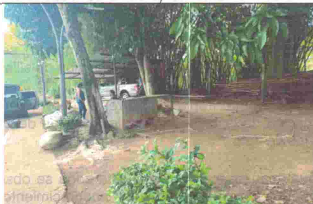
Foto 4. Adecuación terreno, construcción de horno e instalación de sillas.
