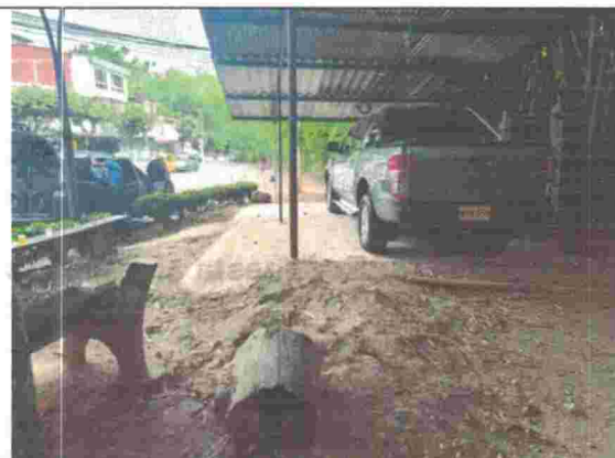
Foto 2. Endurecimiento de la zona para parqueo y sillas
