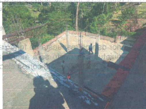
Fotografía 14. Área del proceso constructivo realizada en ronda de protección.
