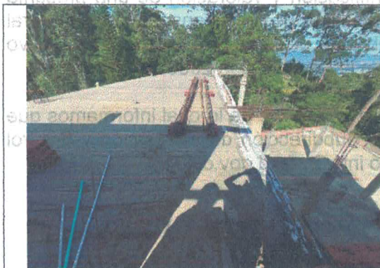
Fotografía 13. Proceso constructivo en ronda de protección hídrica.
