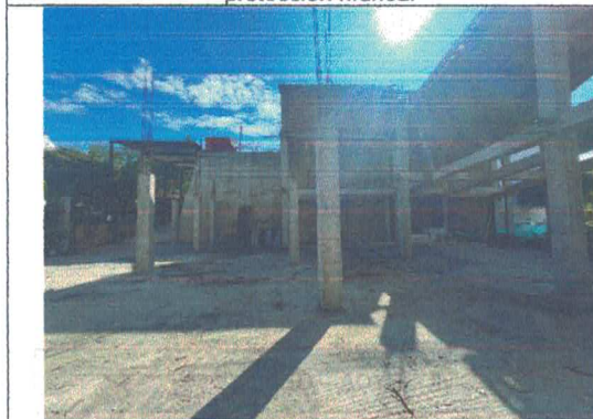
Fotografía 15. Área del proceso constructivo realizada en ronda de protección.
