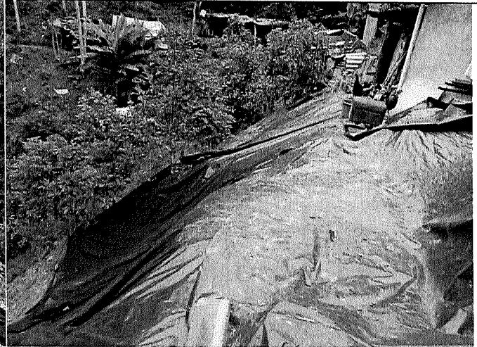
Fotografía 4. Implementación de material geosintético
