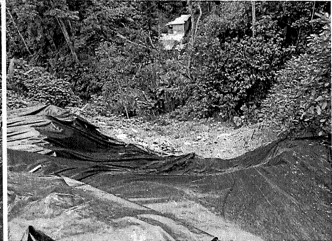
Fotografía 6. Depósitos de escombros y basuras
