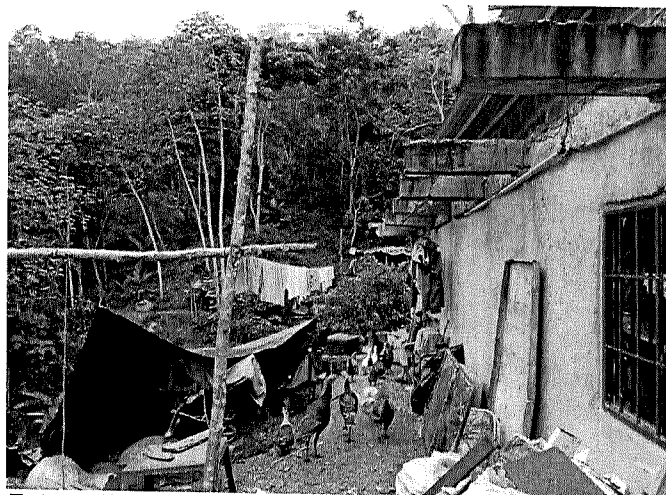
Fotografía 1. Afectación por fenómeno de remoción en masa
