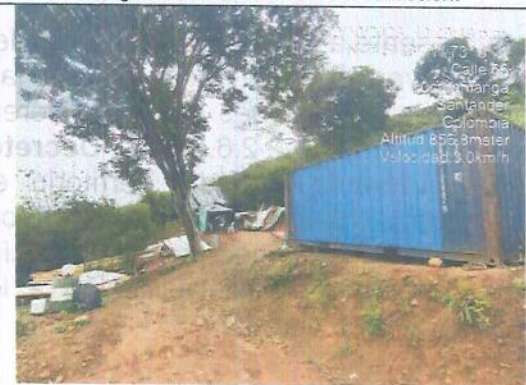
Fotografía 7. Apertura de vía y RCD.
