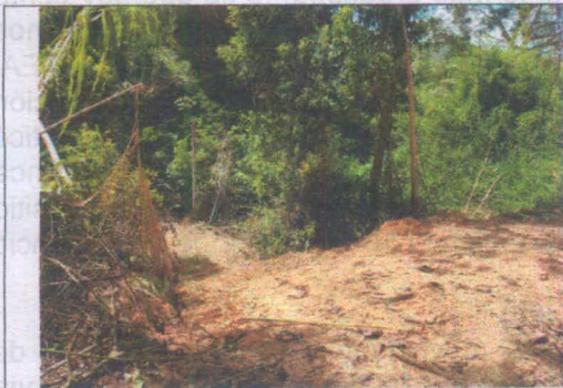
Fotografía 1. Limpieza de terreno para apertura de vía.
