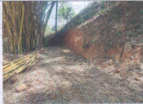
Fotografía 2. Cortes de terreno.
