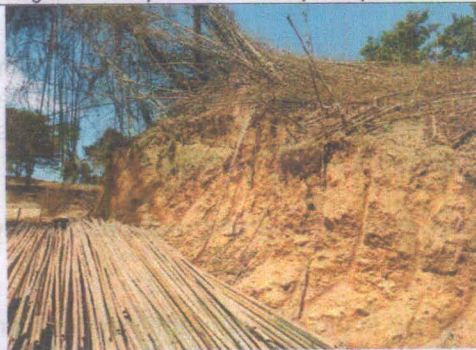
Fotografía 3. Cortes de terreno y productos de tala.
