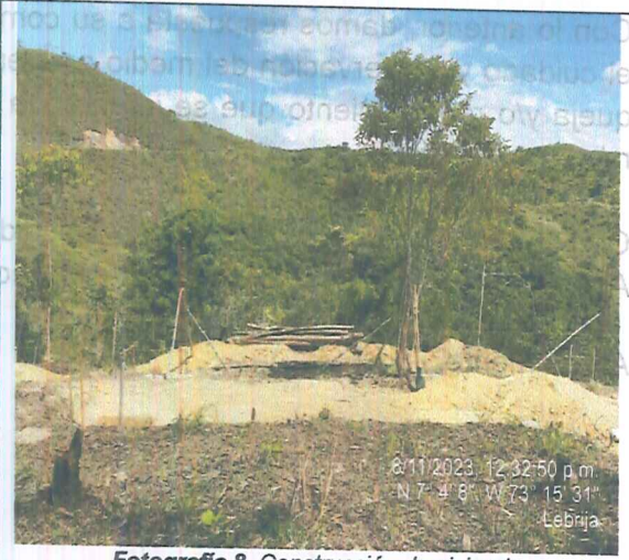
Fotografía 8. Construcción de vivienda
