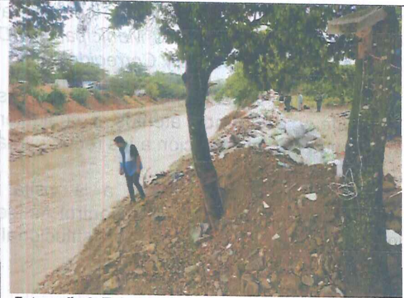
Fotografía 6. Talud conformado por la disposición de RCD.
