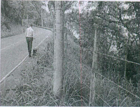
Fotografía 1 Cerramiento del predio con postes de madera y alambre de púa.
