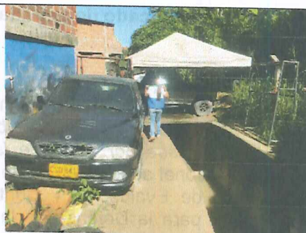
Fotografía 2. Placa construida sobre la canalización.
