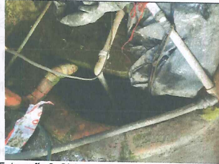
Fotografía 8. Cisterna a través de la cual se realiza captación de agua.
