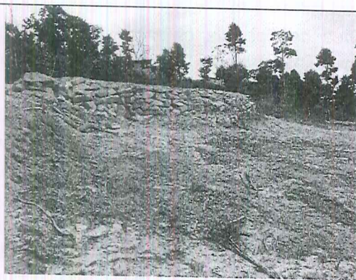
Imagen 2. Gavión construido en el sitio.
