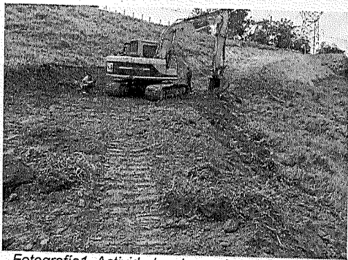
Fotografía 1. Actividades de movimiento de tierras
