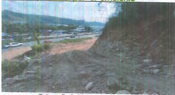
Fotografía 3. Vista talud y apertura
