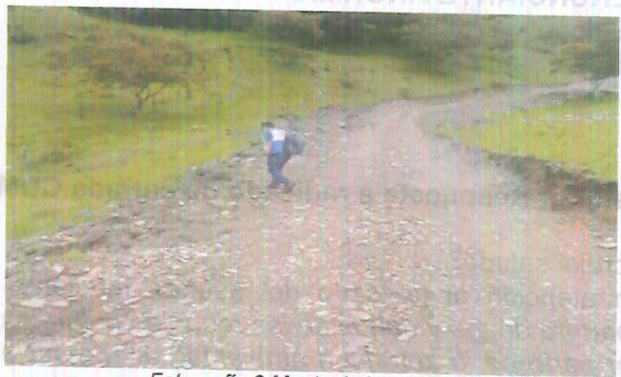
Fotografía 2 Mantenimiento de vía
