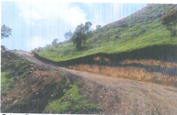
Fotografía 1. Talud formado por trabajos de mantenimiento de vía
