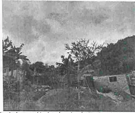
Fotografías 1, 2, 3, 4.- Área objeto de inspección técnica, barrio La Gracia de Dios – Sector el Plan del municipio de Bucaramanga.
