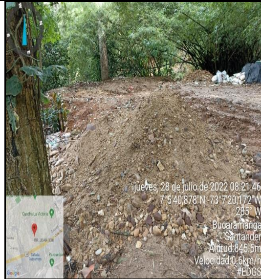
Foto 6 :Disposición de residuos sólidos de construcción y demolición – RCD.
