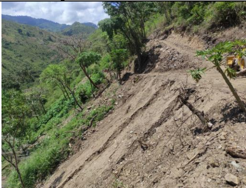
Fotografía 5. Disposición de material sobre el talud.
