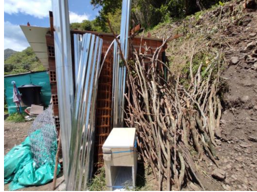
Fotografía 4. Materiales de construcción.
