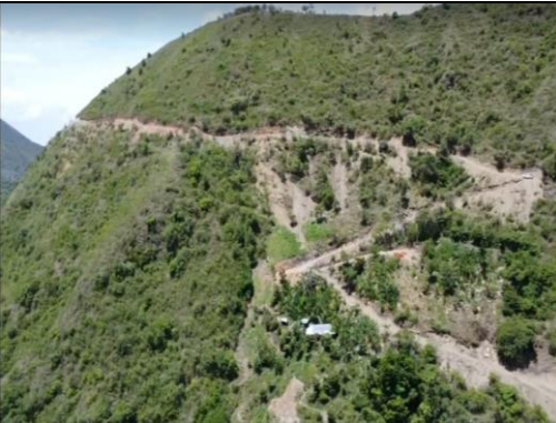
Fotografía 9. Apertura de vía.
