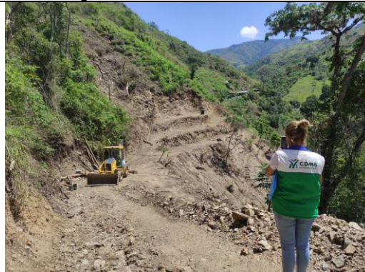
Fotografía 6. Intervención al talud
