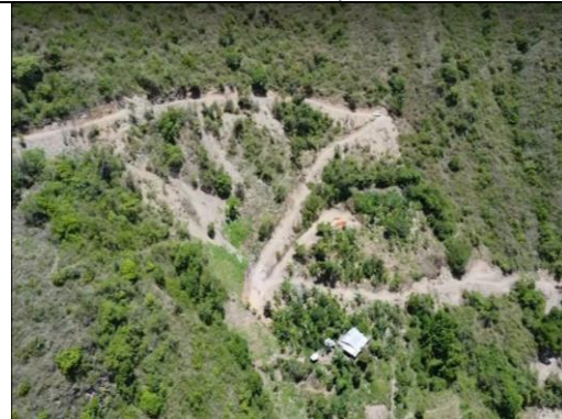
Fotografía 10 Apertura de vía.
