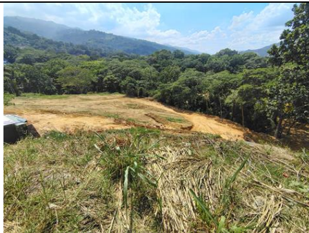
Imagen No. 20. Actividades de movimientos de tierra para conformación de terrazas
