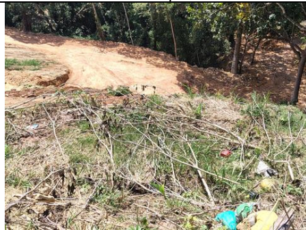
Imagen No. 19. Actividades de movimientos de tierra para conformación de terrazas
