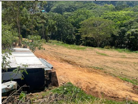
Imagen No. 24. Actividades de movimientos de tierra para conformación de terrazas
