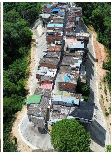
Estado Final de la obra
