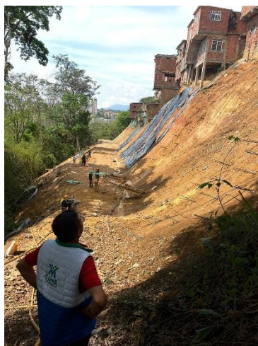
Al iniciar la obra
