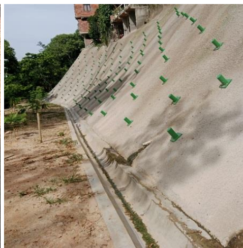
Obra al finalizar
