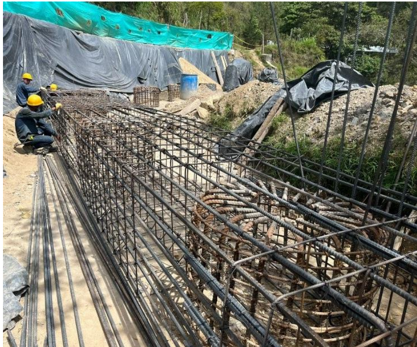
Avance de la obra
