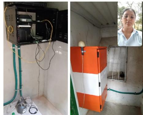
Se realizaron visitas de mantenimiento preventivo y/o correctivo a todas las 8 estaciones que conforman la red acelerográfica de la entidad y las 3 estaciones operadas en convenio con el Servicio Geológico Colombiano, realizando revisión a los equipos, retiro del polvo, animales, humedad, se descargaron los datos generados por los acelerógrafos, se adelantaron los registros correspondientes en la bitácora de acuerdo al procedimiento de operación del Observatorio Sismológico.
