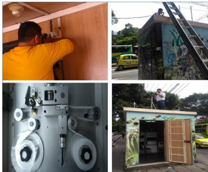
Ilustración 31 Registro fotográfico Mantenimiento Estación Cabecera
