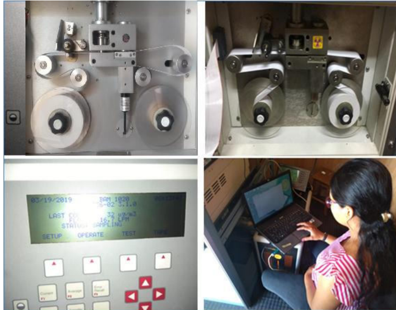
Ilustración 32 Mantenimiento Estación Ciudadela
