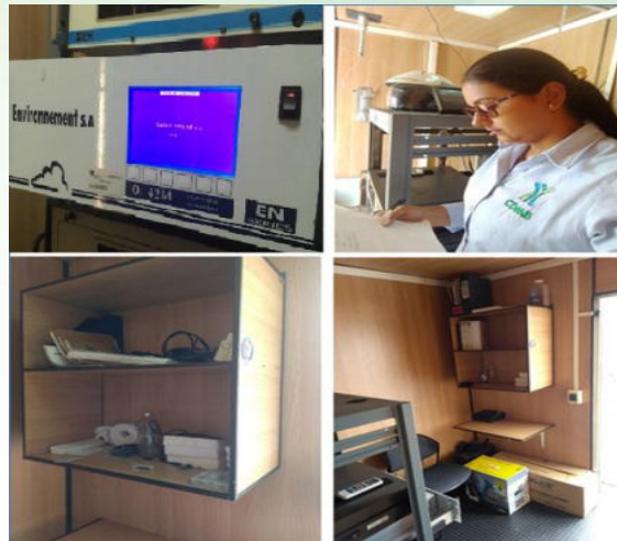
Ilustración 33 Mantenimiento Estación Florida
