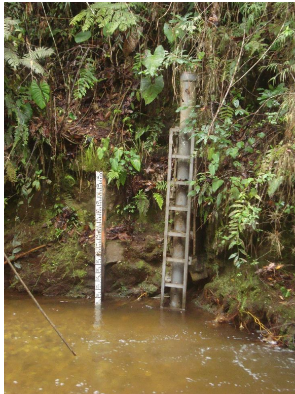
Estación Automática de Nivel Rasgón RO-06
