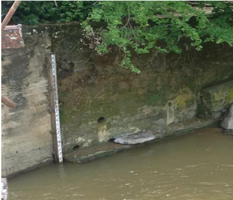
Estación Limnimétrica Vanegas RL-08
